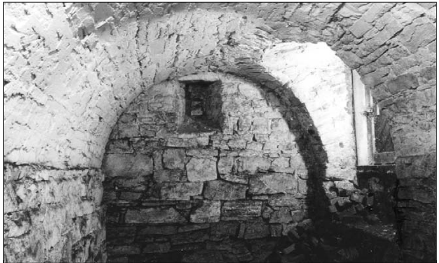
Auf diesem Gewölbekeller könnte der älteste Teil des Hauses Pohl gestanden haben
