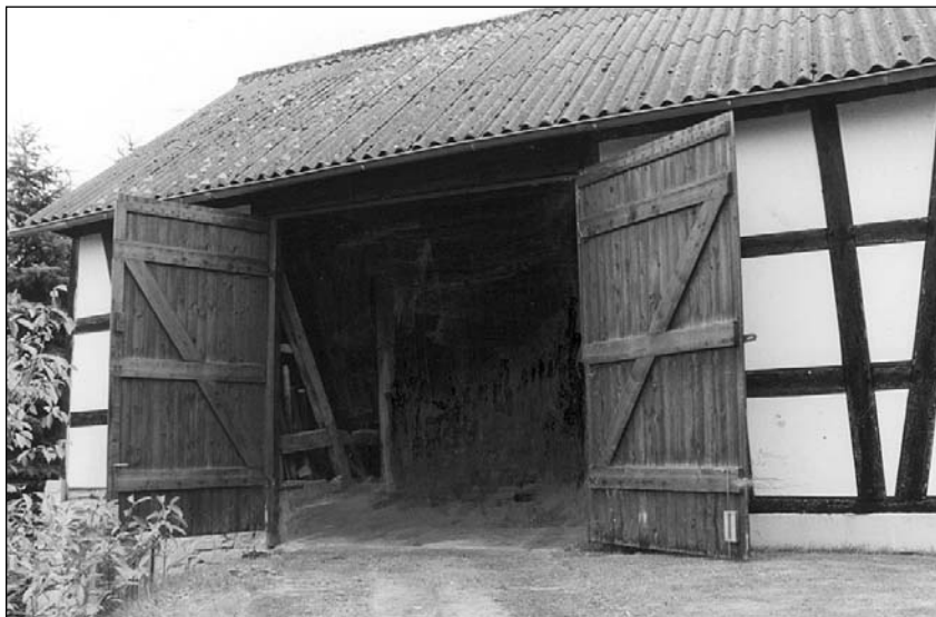
Die »Herbergspforte«, das große Scheunentor am Mühlenweg, Teil einer ehemaligen »Fernstraße«
