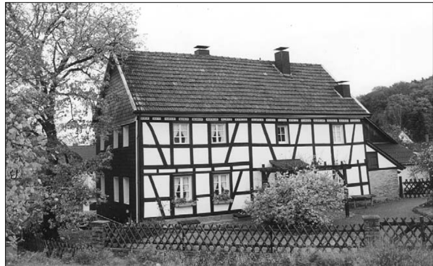
Deutlich sichtbare Unterschiede im Baubild zeigen, dass das Haus in mehreren Zeitabschnitten errichtet worden ist.
