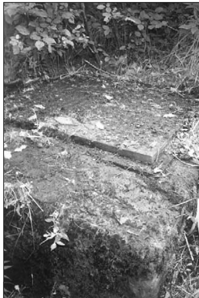
Quellfassung der Lohmarer Wasserversorgung bei Salgert (8)
