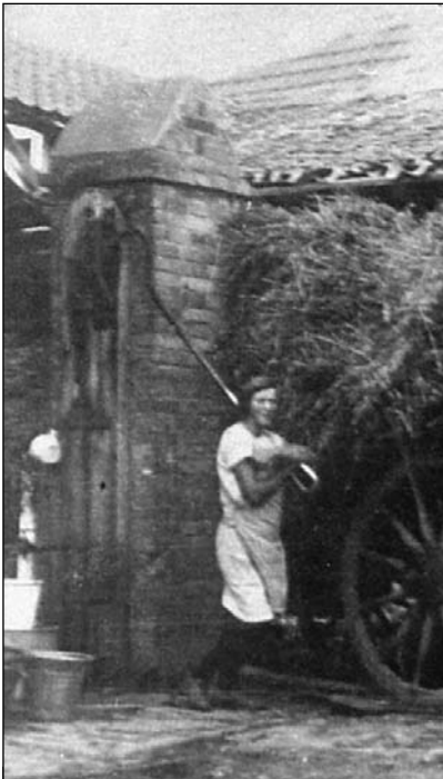
Die Pumpe über dem Brunnen erleichterte die Wassergewinnung (4)
