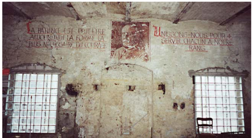
Das Innere der ehemaligen Schnapsbrennerei. Eine Zwischendecke war offensichtlich schon früher entfernt worden. (4)
