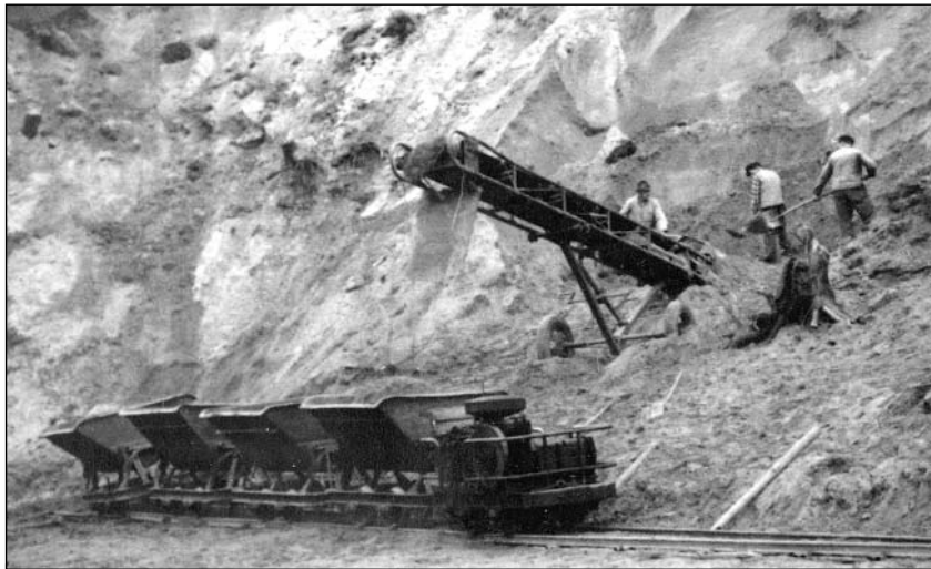
Sandabbau in der Grube Schmiedgasse: Transport mit einer Diesellok (3)
