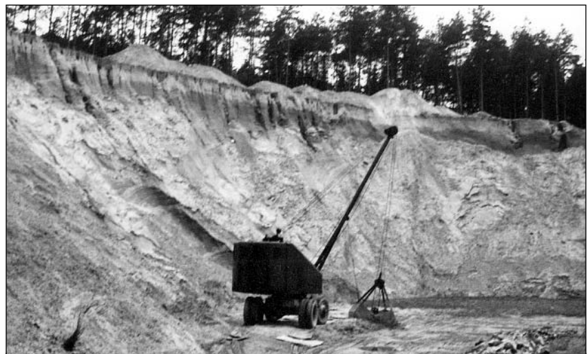
Sandabbau in der Grube Lohmarhohn mit modernem Gerät (4)
