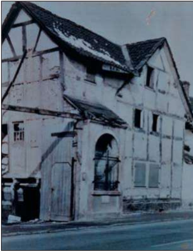
Der demontierte Mendener Ingerbergshof lagert im Freilichtmuseum (5)
