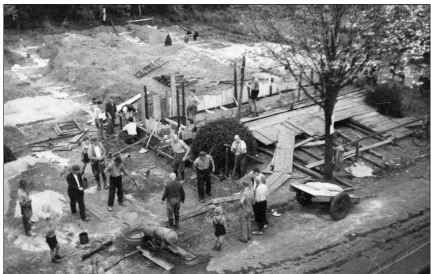
Die Ausschachtungsarbeiten begannen im Sommer 1952 (2)
