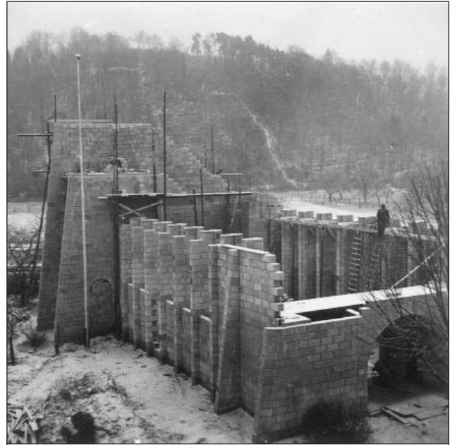
Die Außenwände waren schnell hochgezogen (4)
