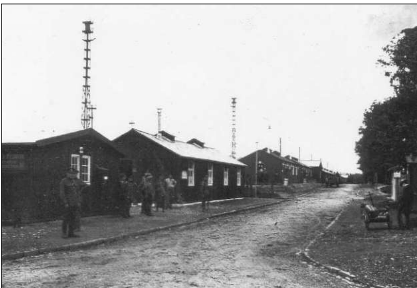
Die Strommasten im Waldlager der Alliierten in Lohmar überragten die Baracken (5)
