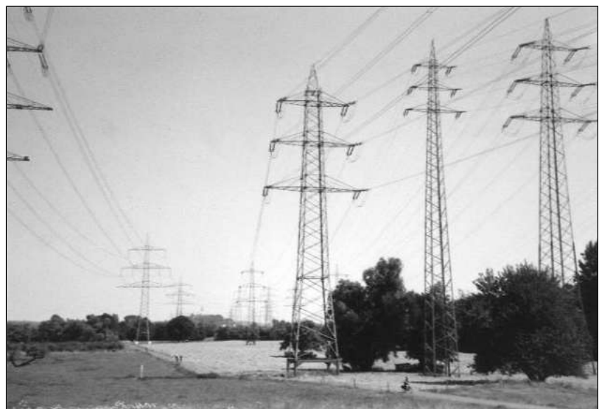
Vom Braunkohlengebiet westlich von Köln verlaufen heute die Hochspannungsleitungen durch die Sieggaue (2)
