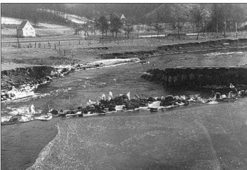
Auf der Honsbacher Seite der Agger ist die große Lücke im Wehr zu sehen; rechts die Reste der Stauanlage. (12)
