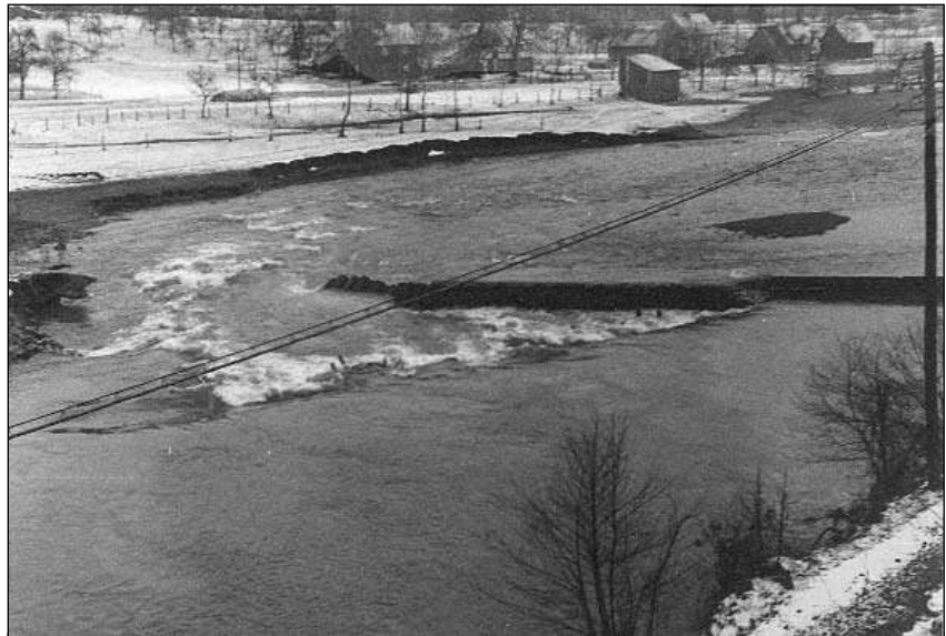
Bruch des Wehrs an der Agger nach dem verheerenden Hochwasser im Winter 1940/41; im Hintergrund Gebäude von Honsbach. (11)
