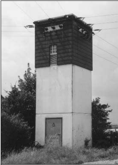
Von Weeg verlaufen die Leitungen noch heute in vier Richtungen. (3)
