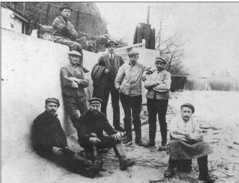
Reparaturarbeiten am Aggerwehr (von links nach rechts), sitzend: unbekannt, Julius Frackenspohl (Kern), Josef Schwamborn (Honsbacher Mühle); stehend: Heinrich Schiffbauer (Müllerhof), Alfred Becker (Aggerhof), Josef Stocksiefen (Aueler Hof), Hugo Wasser (Hähngen); auf der Mauer: unbek. (7)
