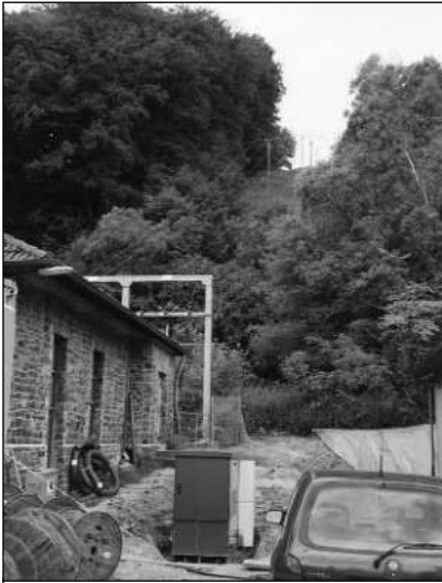
Die Leitungen des RWE führen noch heute die Trasse von Bacher- mühle nach Windlöck hinauf. (14)
