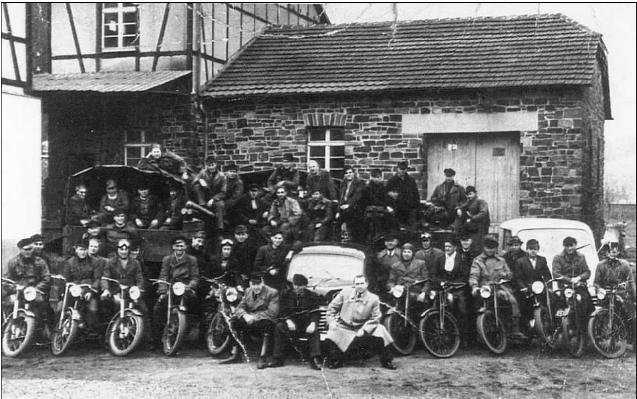
Das Wartungsteam des Wahlscheider Elektrizitätswerkes (10)
