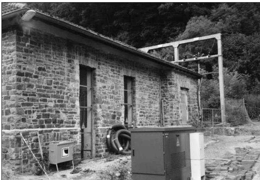
Das umgebaute Betriebsgebäude des Elektrizitätswerkes in Bachermühle. (13)
