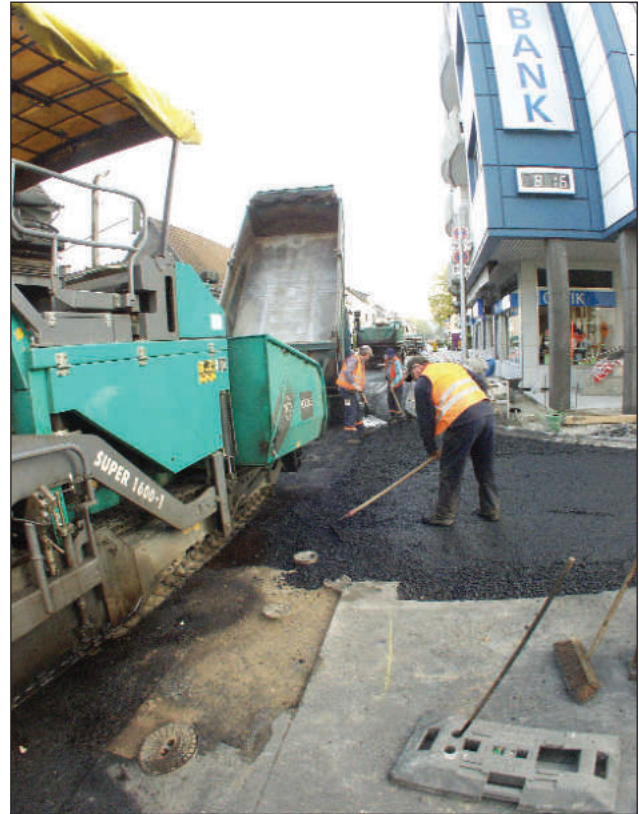
Die Fahrbahn an der Einmündung Rathausstraße wird asphaltiert (Oktober 2005)
