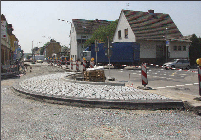
Beim Kreisverkehr an der Kreuzung Auelsweg/Bachstraße ist eine Hälfte fertig (Juli 2005)
