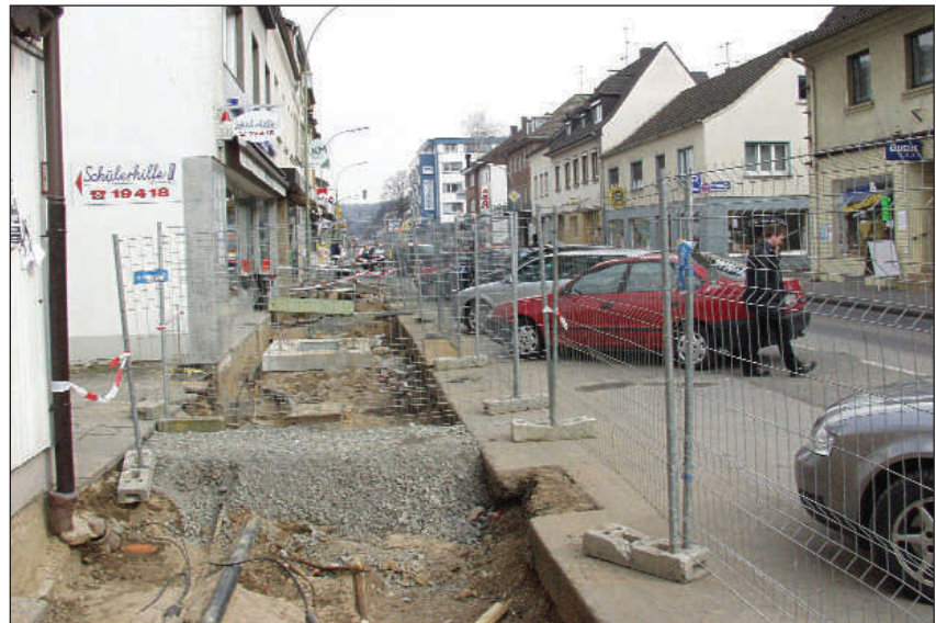
Vor dem Neubau der Gehwege werden die Versorgungsleitungen saniert (März 2005)
