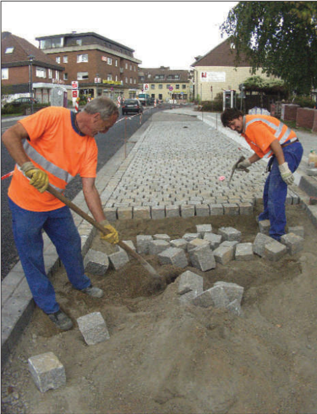
Abschließende Pflasterarbeiten vor der Stadtbücherei (September 2005)
