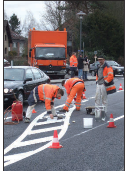
Mit Markierungsarbeiten wird der Umbau der Hauptstraße abgeschlossen (Februar 2006)
