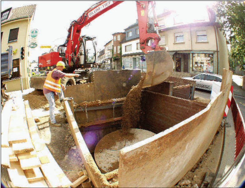
Beginn der Kanalerneuerung an der Einmündung der Kirchstraße (August 2004)
