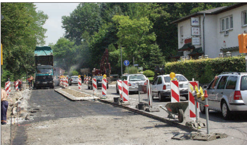
Beginn der Fahrbahnerneuerung vor der Einmündung Wiesenpfad (Juli 2005)
