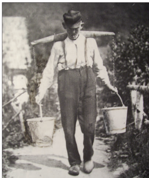
Bei akuter Trinkwassernot schleppten so genannte „Wasseresel“ das kühle Quellnass bis weit ins Dorf)
