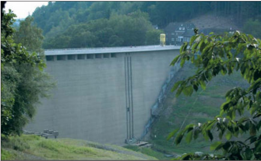
Aggertalsperre, Sanierung 2001-2002 Erneuerung der Mauerkrone und der Vorsatzwand (6)
