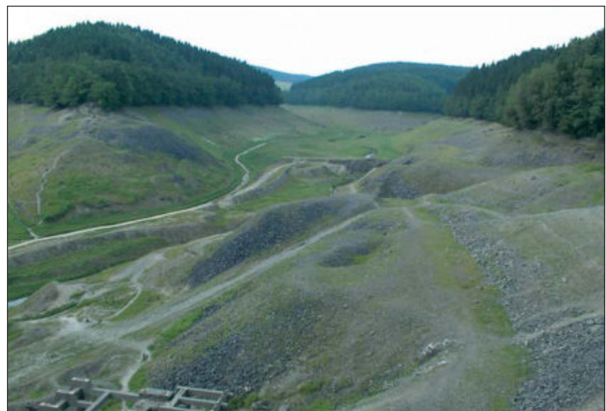
Die Aggertalsperre 2001-2002 Ergänzungs- und Sanierungsmaßnahmen. Verankerung des Horizontalrisses und Erneuerung der Mauerkrone und der Vorsatzwand Aggerarm (7)
