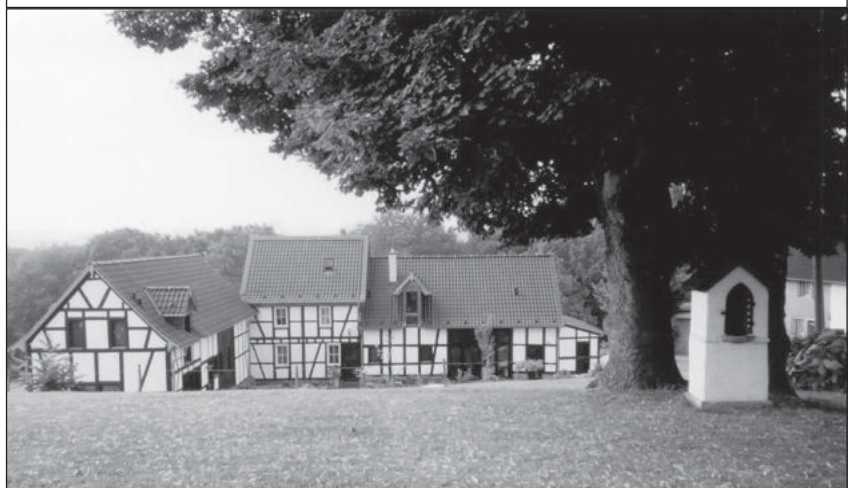
Anlage nach dem Umbau 2001
