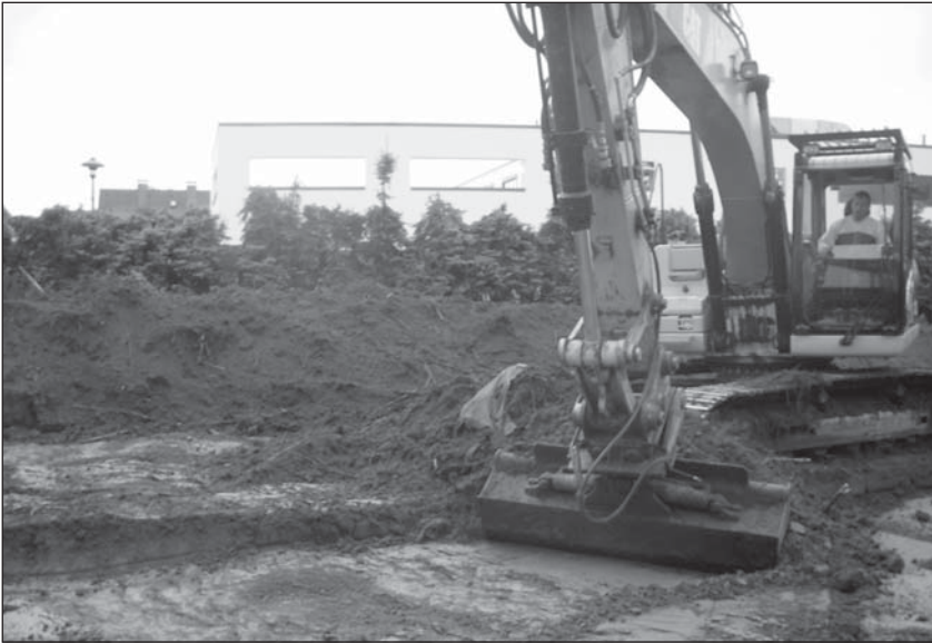
Mit Bagger und von Hand durchsuchten Wissenschaftler an der Vila-Verde-Straße im vergangenen November metertief den Boden nach Zeugnissen der Vergangenheit (2)
