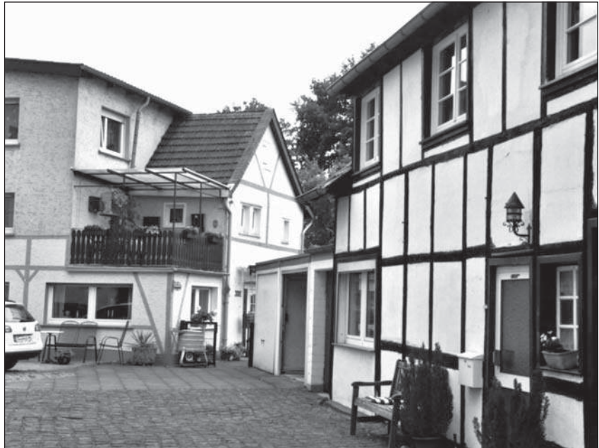
Noch vollständig erhalten, aber total überbaut existiert der alte Fronhof bis heute (3)
