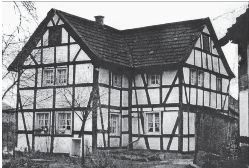
Der wohl einmal wehrhafte ehemalige Wohntrakt des Fronhofes auf einem schon viele Jahrzehnte alten Foto (4)
