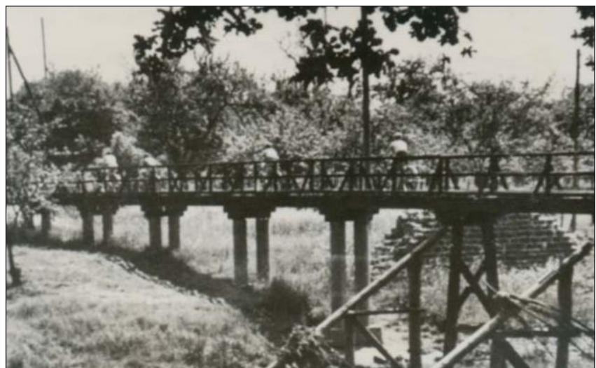
Hochstehende Notbrücke über die Agger mit dem dahinter sichtbaren Landpfeiler der Stahlbrücke (7)
