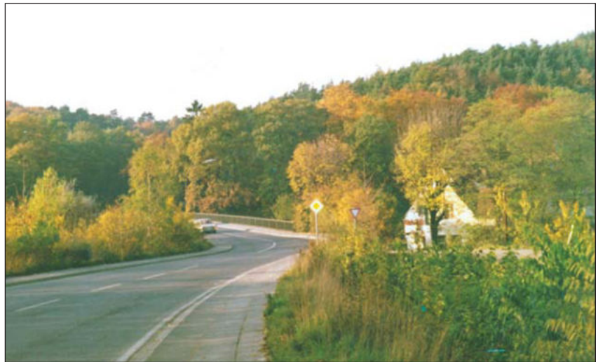
Erste Stahlbetonbrücke über die Agger (8)
