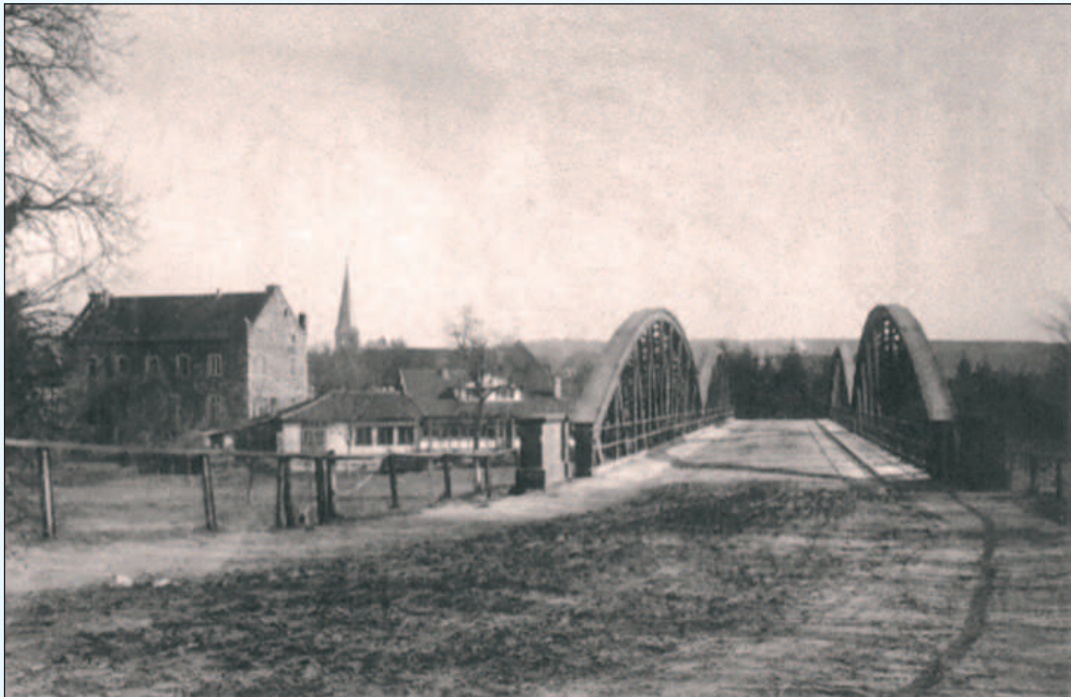
Bild 6: Die Aggerbrücke vor der Sprengung
