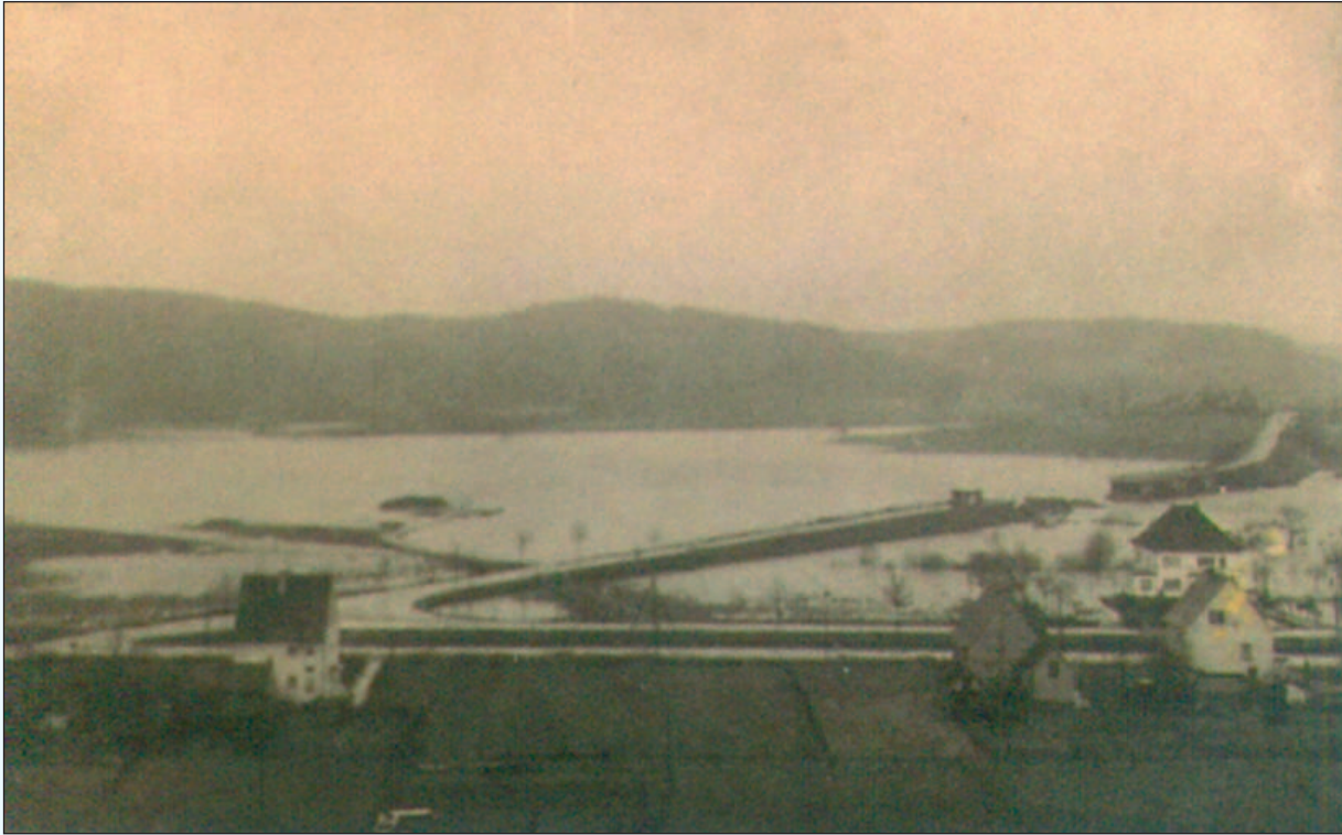
Bild 7: Das Hochwasser in Donrath mit der gesprengten Brücke über die Agger nach Rösraith Links die Donrather Kreuzung mit Haus Broich, dann Haus Busch und Haus Burger, und dahinter Haus Jakobs
