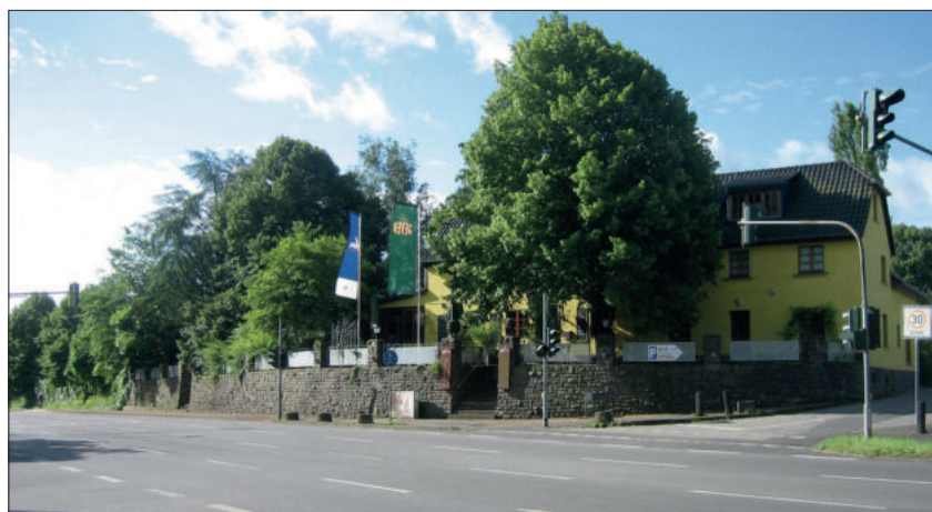
Unten: Die Gaststätte heute, mit der ca. 50 Meter langen, damals gebauten Stützwand. (5)
