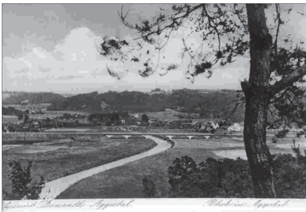
Auf dieser Abbildung sind beide, im Vordergrund die neue und 300 Meter flussaufwärts die alte, gemauerte Fünfbogenbrücke, die am 4.11.1940 zum Einsturz kam, zu erkennen (7)
