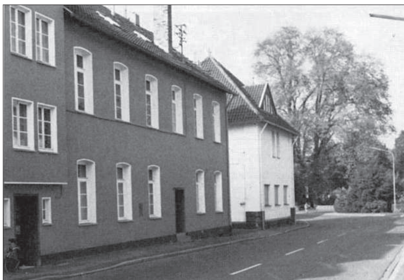
Die alten Schulgebäude in der Kirchstraße, etwa um 1980 (2)
