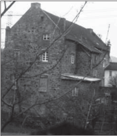
Die Südostecke des Burghauses. Deutlich sind die störenden Anbauten und der mit Pultdach abgeschlossene Risalit zu erkennen. (4)
