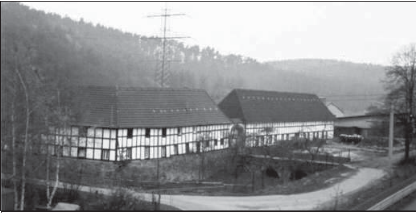
Blick auf die Vorburg von der Brücke über die Autobahn (2)
