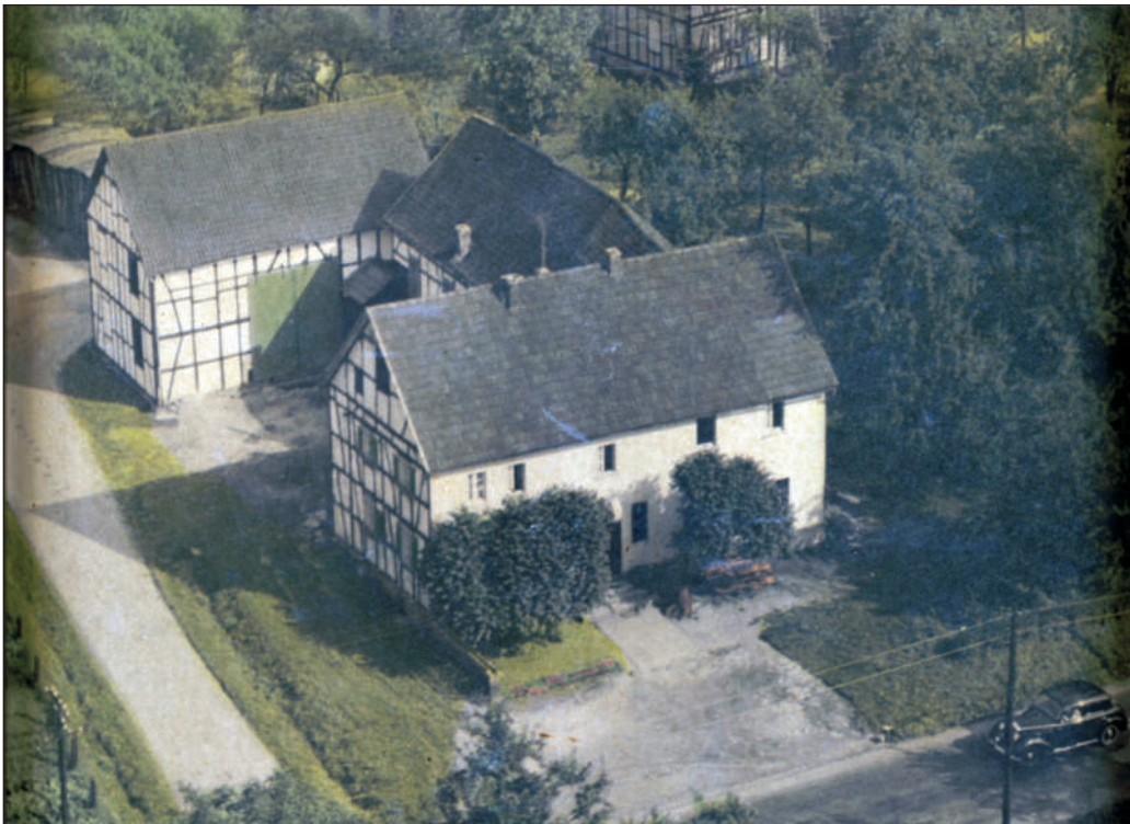
Ansicht des Gesamtgebäudes, Anfang der 50er Jahre. Gast-/Wohnhaus, Stall und Scheune und im Vordergrund die Zeithstraße B56 (18)
