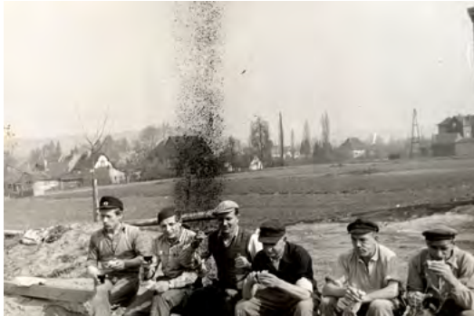
Hausbau Lohmar. Bildrand rechts sind Gebäude des Sägewerks Sauer mit dem Geburtshaus des Fabrikanten und Heimatforschers B. Walterscheid-Müller
