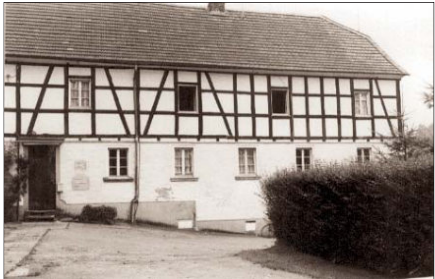
Bachermühle, Westtraufe (Foto: 1974-76) (1)
