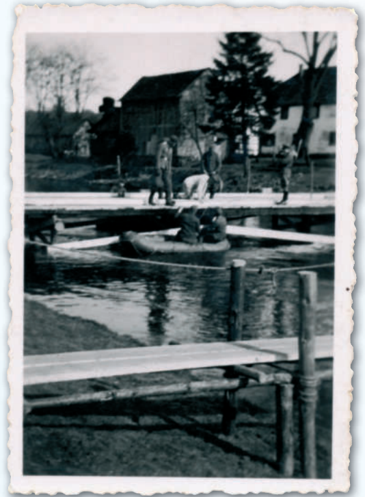
Soldaten bauen den neuen Fußgängersteg. Im Vordergrund der Notsteg (10)
