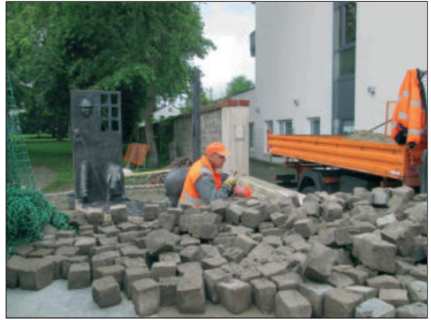
Restarbeiten mit Pflastersteinen. (7)
