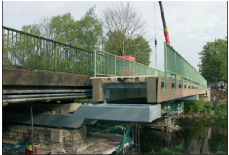
Die Rad- und Gehwegbrücke an der Wahlscheider Straße ruht auf Traversen aus Stahl
