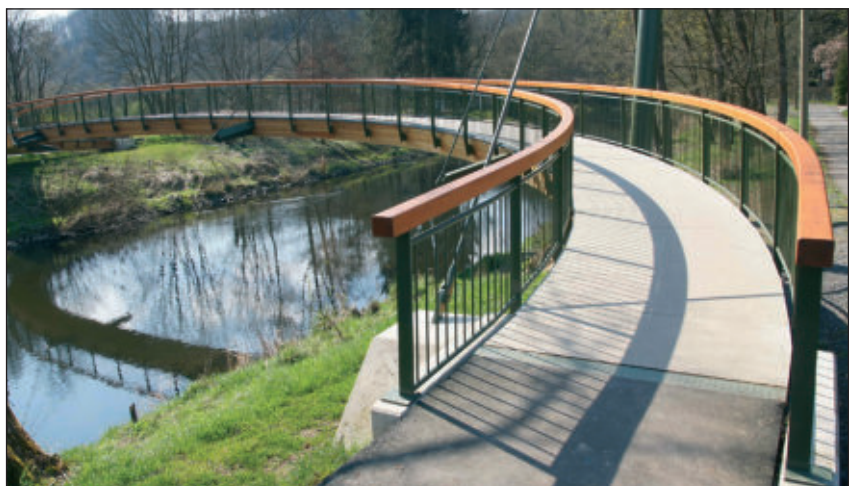
Mit elegantem Schwung überspannt die Aggerbogen-Brücke den Fluss
