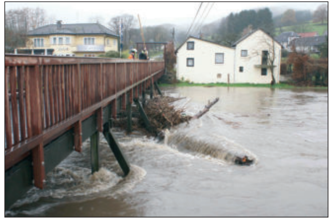
Am 13. November 2010 droht der Einsturz der alten Brücke bei Schiffarth
