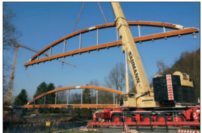
Ein schwerer Mobilkran hebt die Bauteile der Brücke bei Kreuznaaf in Position
