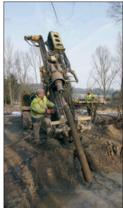
Tiefe Erdbohrung für eines der Abspannseile an der Aggerbogen-Brücke
