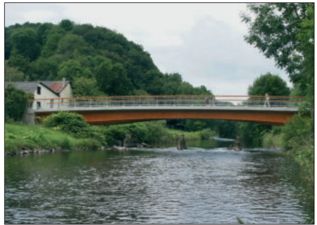
Die vom Rhein-Sieg-Kreis gebaute Brücke bei Schiffarth ist fertig gestellt
