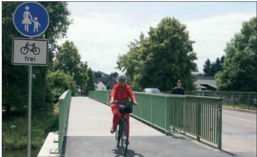
Die fertige Brücke für Radler und Fußgänger an der Wahlscheider Straße
