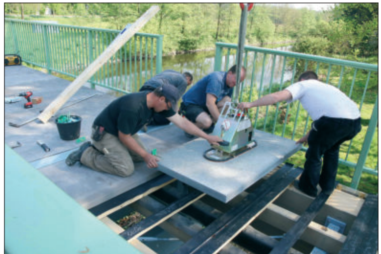
Die Fahrbahn der Brücke Wahlscheider Straße besteht aus Grauwacke-Platten
