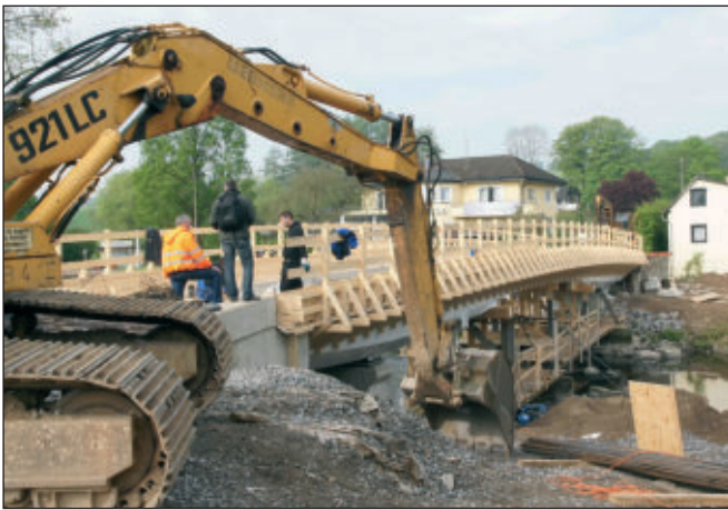
Die neue Brücke bei Schiffarth aus Beton und Holz in der Bauphase
