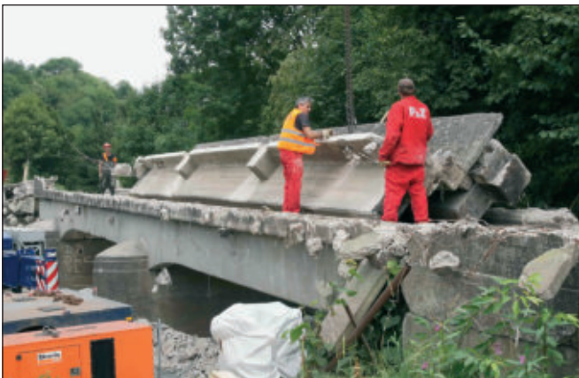
Die alte Betonbrücke bei Kreuznaaf wird beim Abriss in Teile zerlegt
