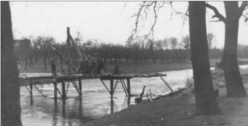
Lohmarer Bürger begannen schon kurz nach dem Einmarsch der Amerikaner in Selbsthilfe eine ca. 2 Meter breite Holzbrücke über die Agger zu bauen. Die Notbrücke war tiefliegend, höchstens 1m über dem Wasserspiegel angelegt. Fertiggestellt und befahrbar war sie etwa Mitte Juni 1945. Aber schon beim ersten Hochwasser wurde die Brücke weggeschwemmt, es gab für einige Wochen nur die Möglichkeit, von Altenrath über Donrath nach Lohmar zu kommen.
