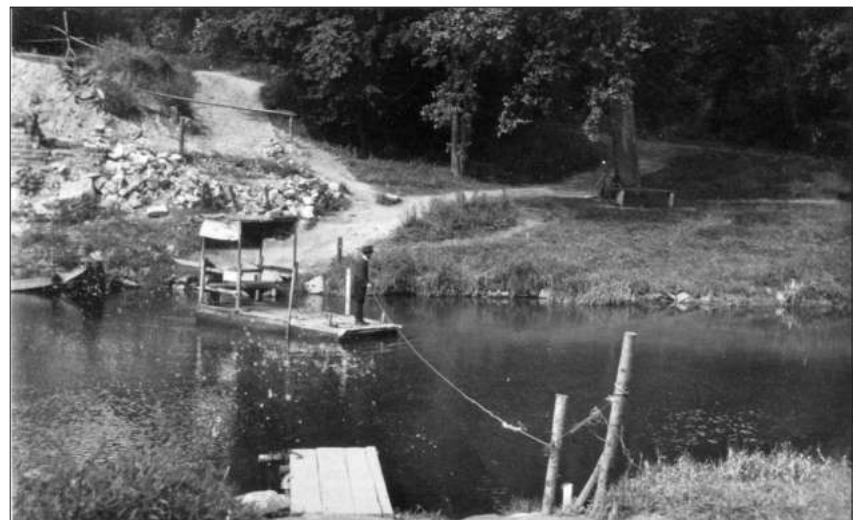
Willi Weppler aus Lohmar baute eine Fähre und nahm im Frühjahr 1946 direkt neben der gesprengten Aggerbrücke seinen Fährbetrieb auf.
