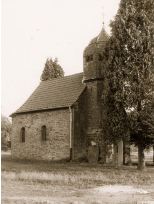
Die Kapelle in Heide vor der Renovierung. Am unteren Bildrand sind noch die Erdhügel der ehemaligen Mülldeponie zu erkennen, die bis dicht an die Kapelle heranreichte. ①
