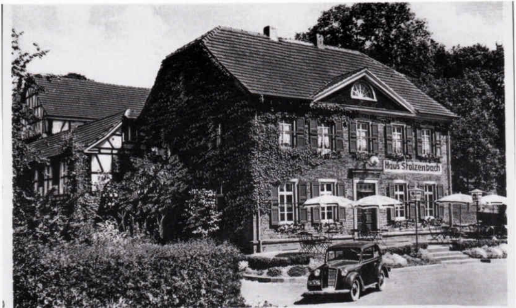
Haus Stolzenbach im Aggertal bei Wahlscheid
